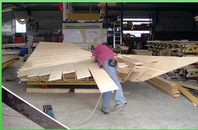
**Assemblage du coffrage charpenté pour le site "Technik - Wand"**
