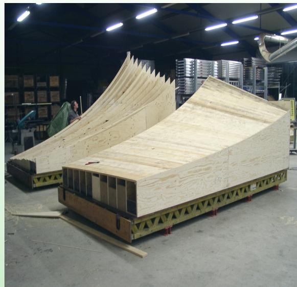
... échelle réelle 1/1 d'un détail du coffrage
