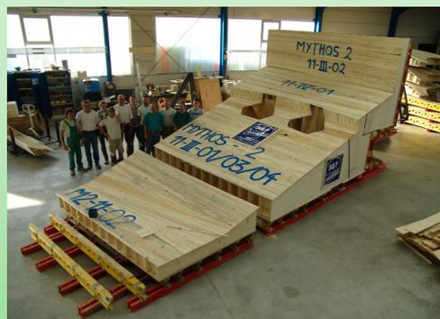
Éléments de coffrage en cours d'assemblage partiel
